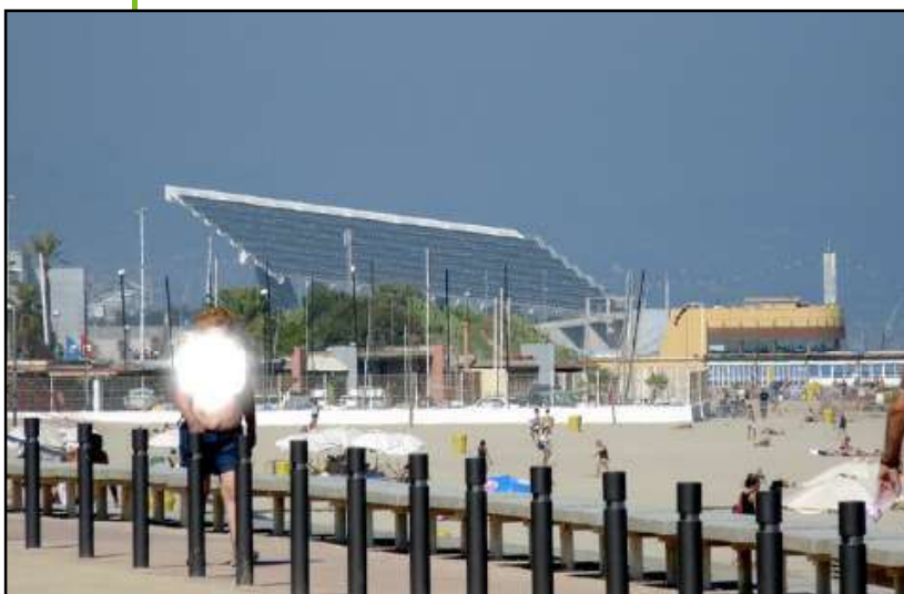
Gigantesco "pannello fotovoltaico" sulla spiaggia di Barcellona
