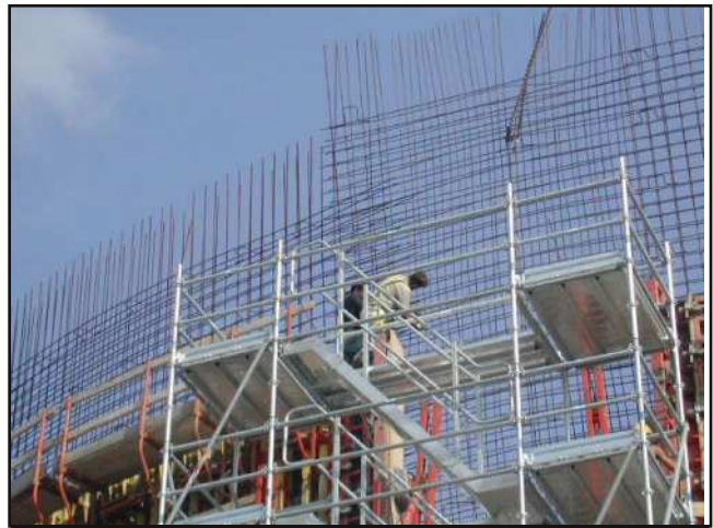
Impianto Cementilce (RA) in costruzione
